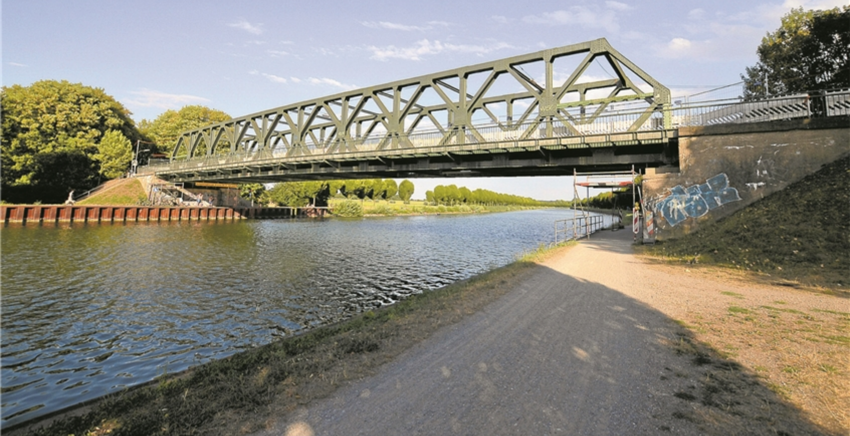
Die Aufnahme der Schwieringhauser Kanalbrücke in die Denkmalliste sorgt für wirtschafts- und verkehrspolitische Debatten.
